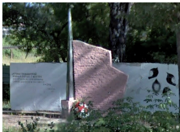
Вид памятника до реконструкции
