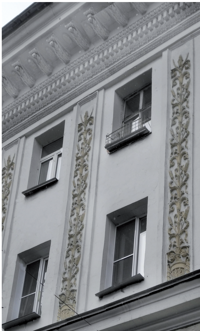
Фрагмент фасада с лопатками с барочным орнаментом
