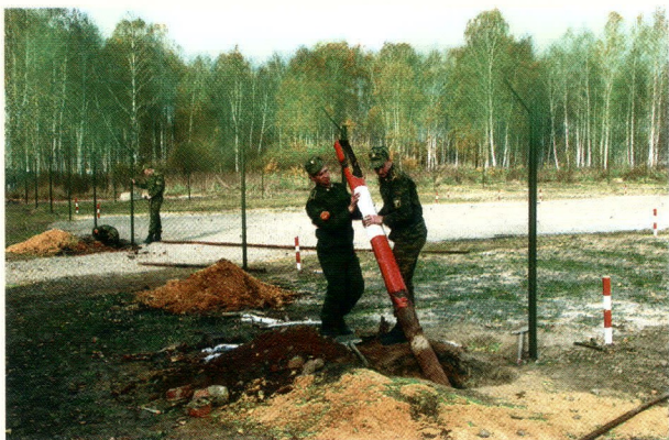
Ограждение территории площадки длительного хранения техники
