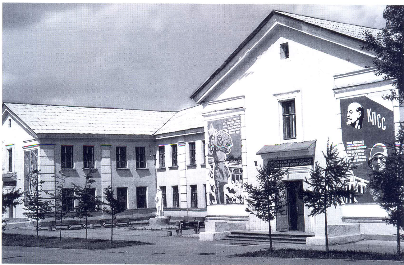
Казарменные помещения 3-го батальона. 1972 г.
