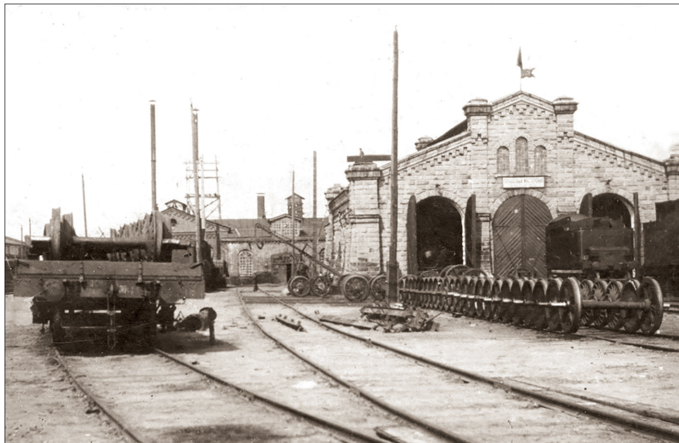
Здание паровозного депо станции Челябинск.
