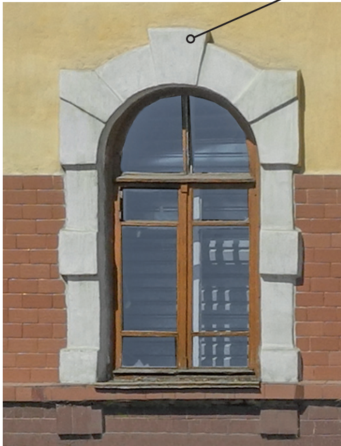
Оборужение оконного проема
