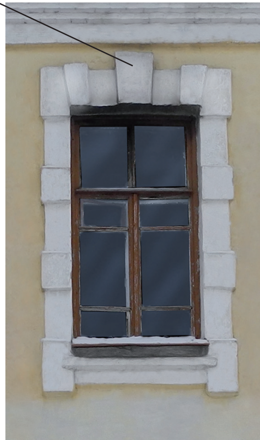
Оборужение оконного проема
