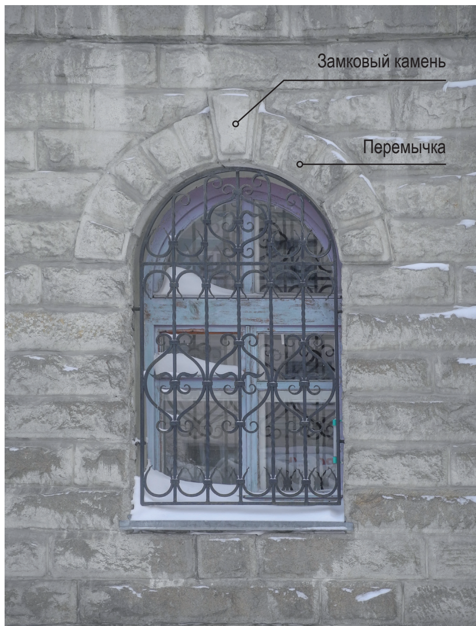
Оборужение оконных проемов
