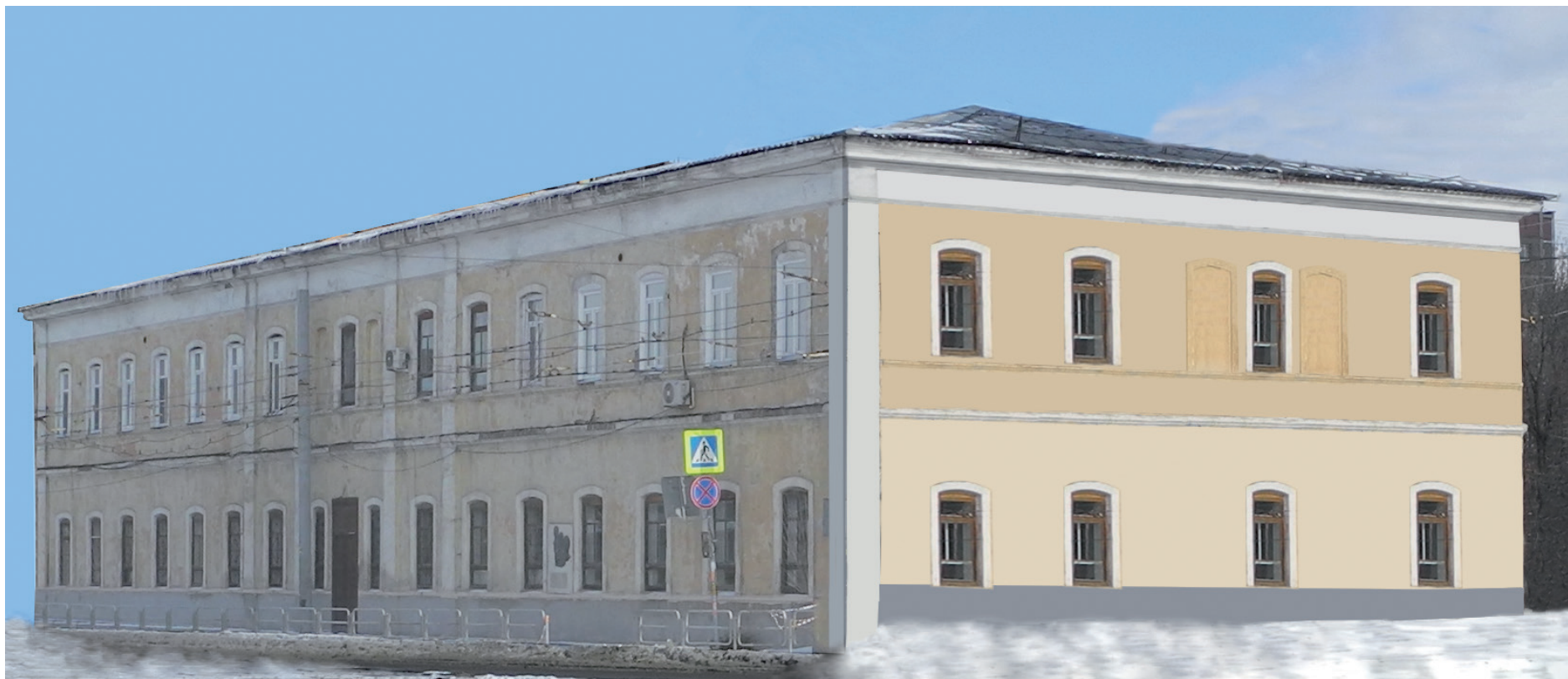
Вид с юго-запада
