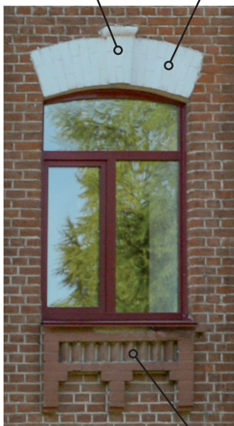
Обформление оконного проема
