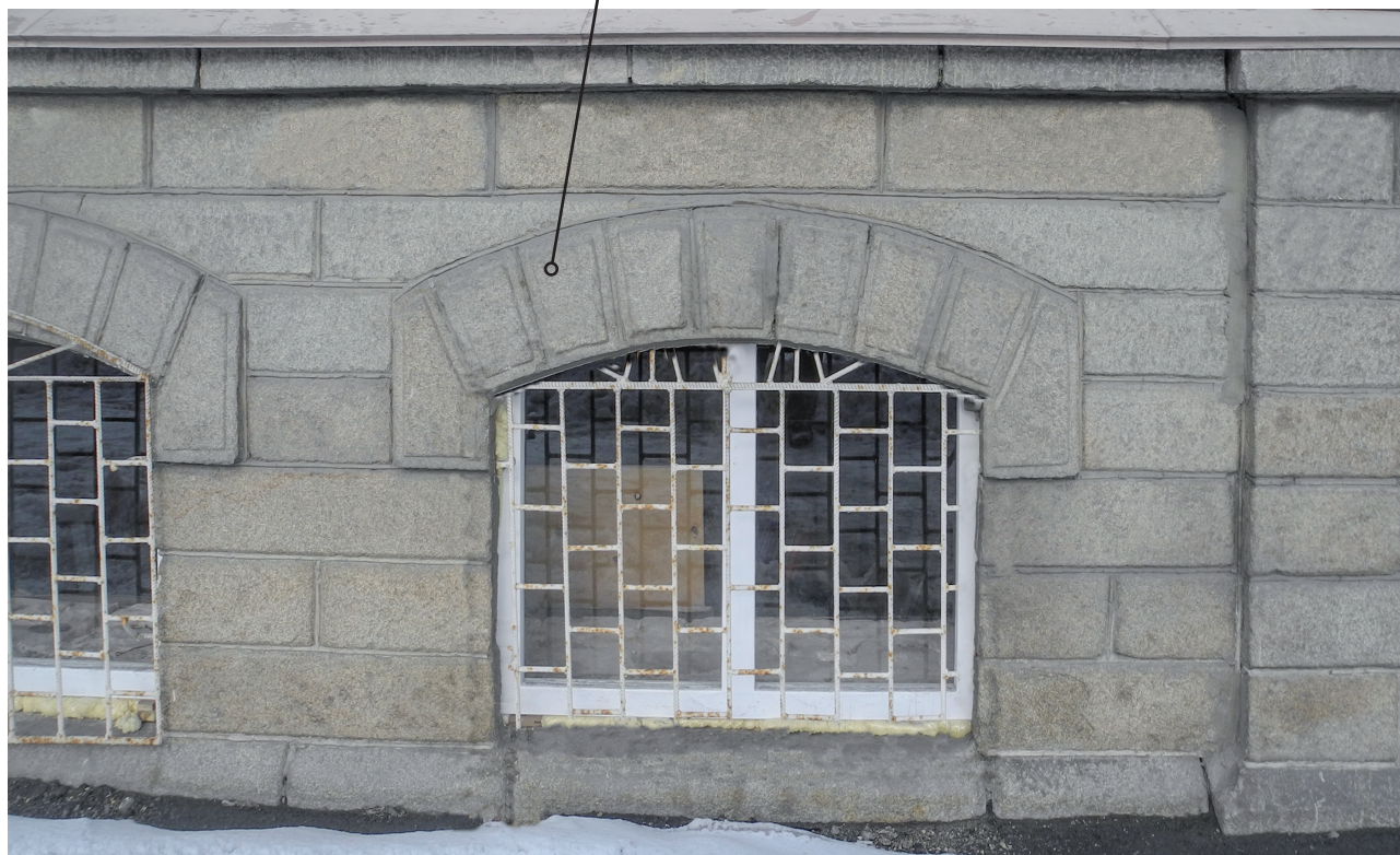
Фрагмент цокольного этажа
