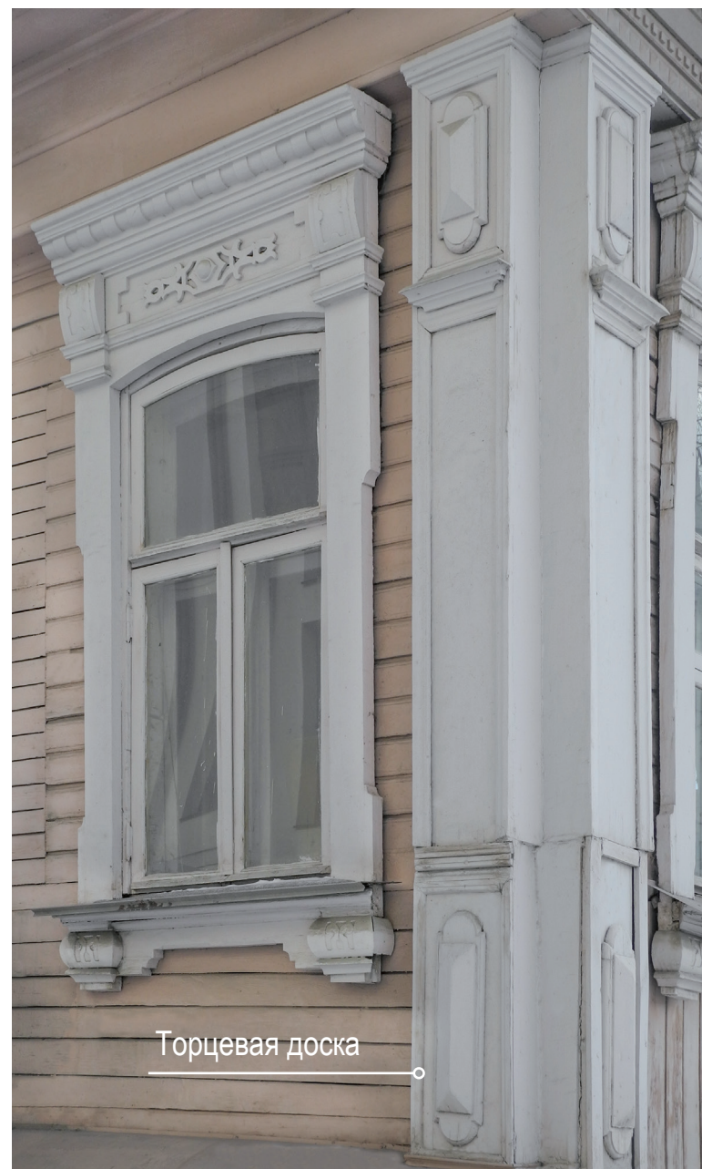
фрагмент восточного фасада
