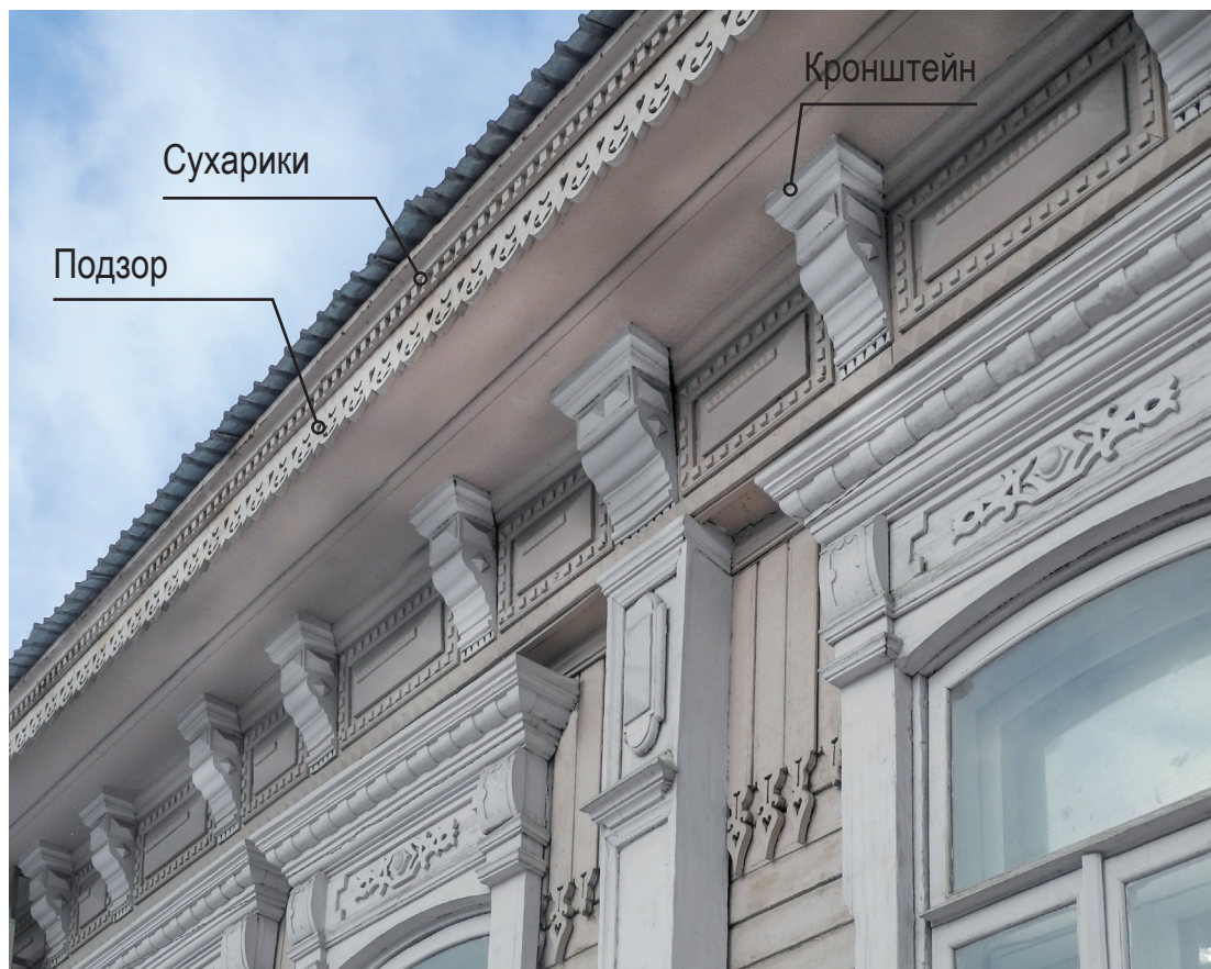
фрагмент восточного фасада
