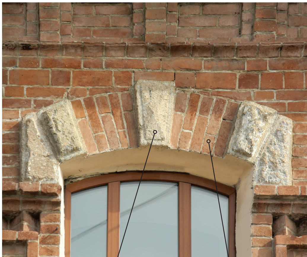
Сформление оконного проема
