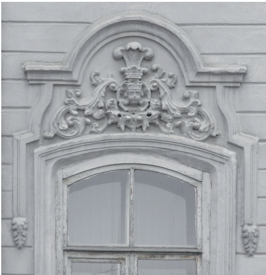
Оборужение оконного проема
