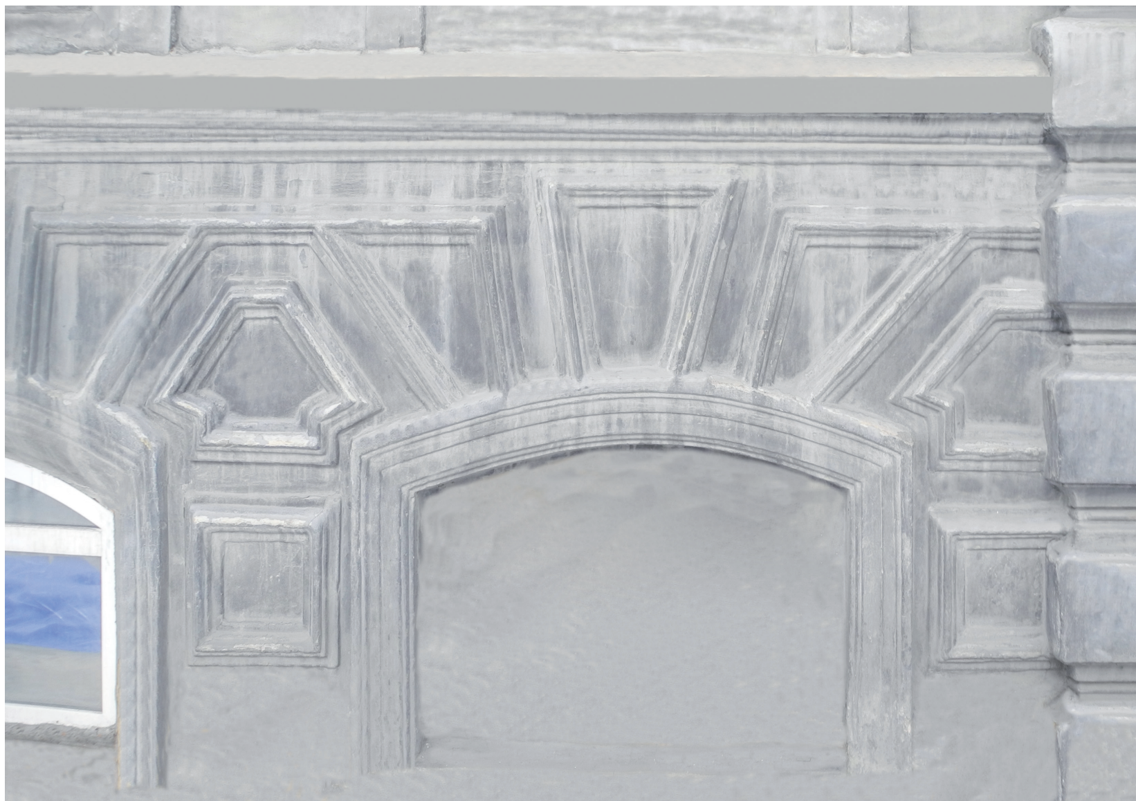
Обформление оконного проема цокольного этажа
