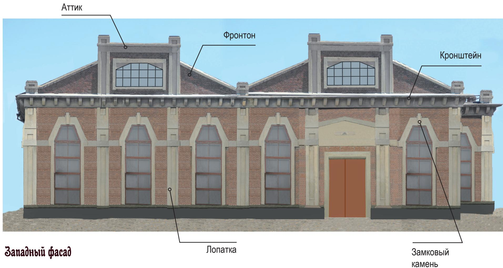
Первая теплоэлектростанция города городская электростанция (1915—1916). Построена и оборудована Русским акционерным обществом «Сименс — Шуккерт». Здание уникально тем, что здесь впервые в городе применен прием безбалочного монолитного железобетонного перекрытия.
