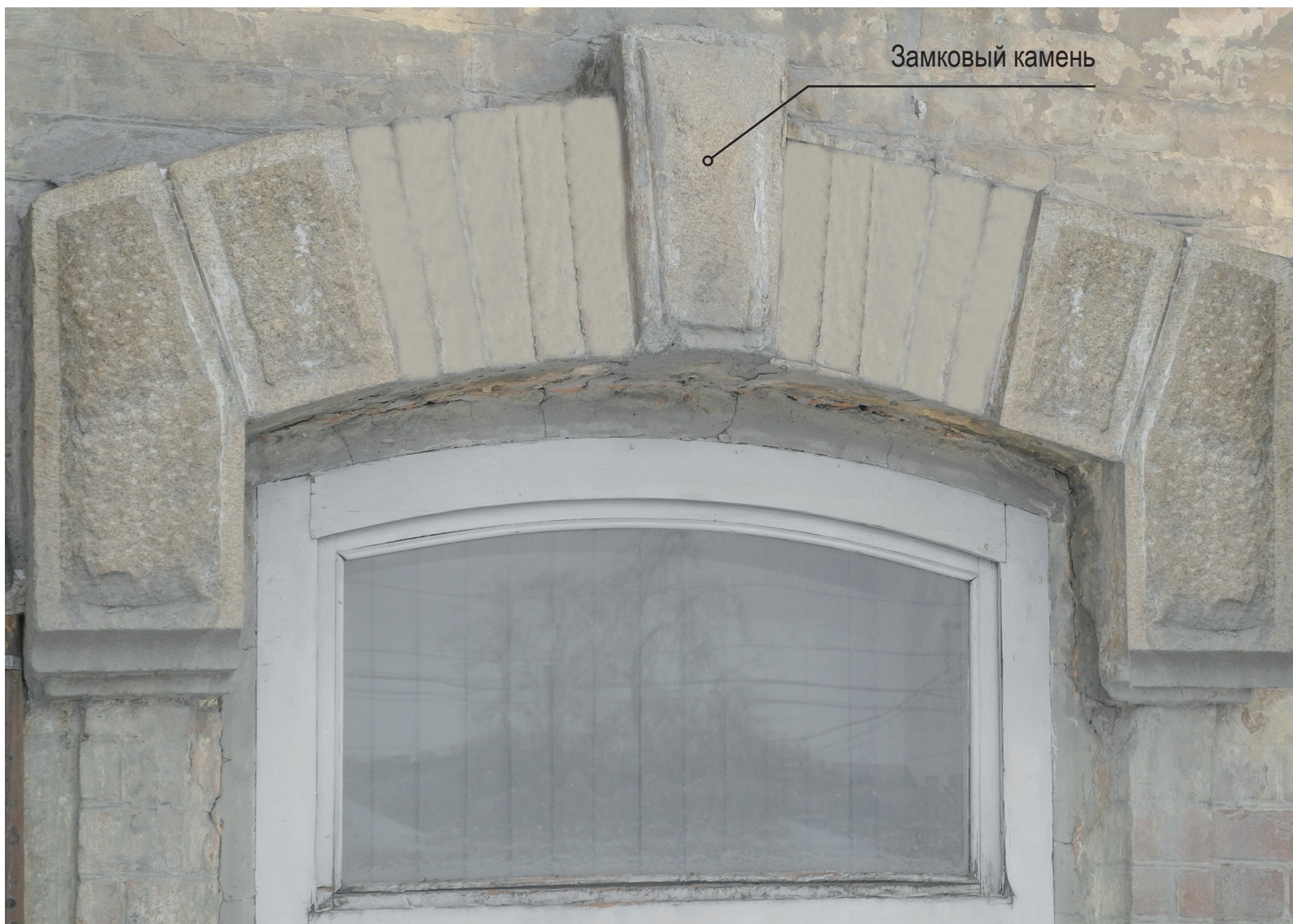
Обформление оконного проема
