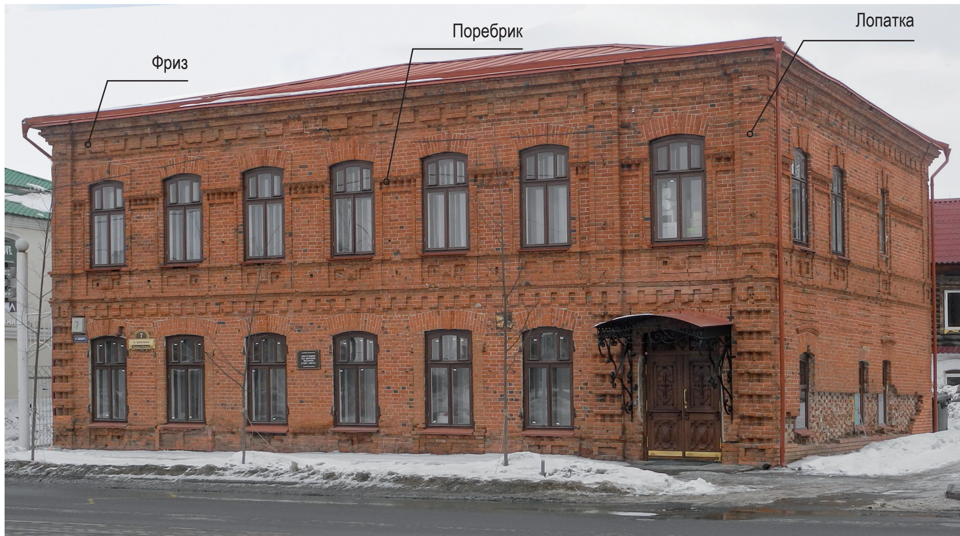
Вид с юго-запада
