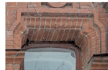
Оконный проем в арке с заплечиками
