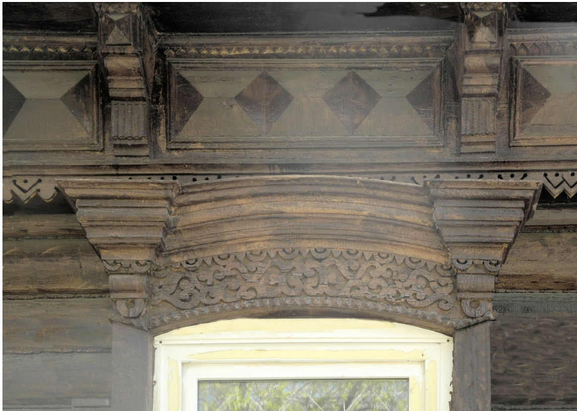
Фрагмент западного фасада
