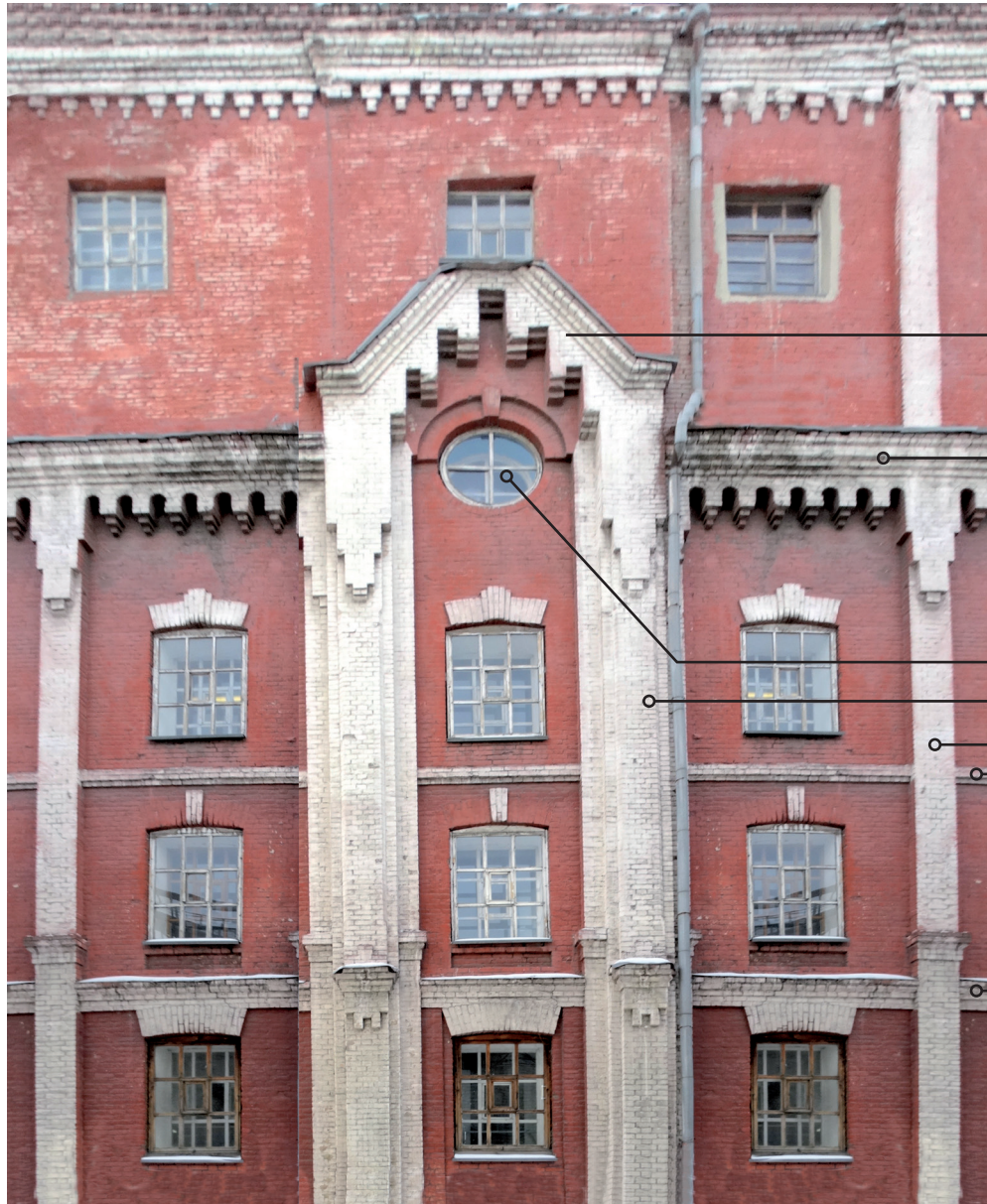
фрагмент северного фасада
