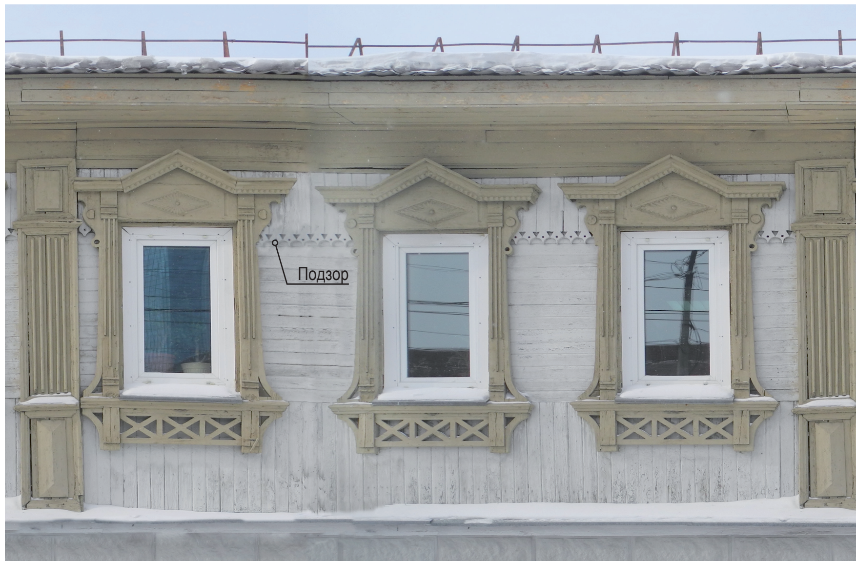
Фрагмент восточного фасада
