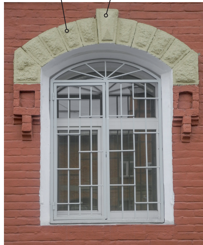
Обформление оконного проема
