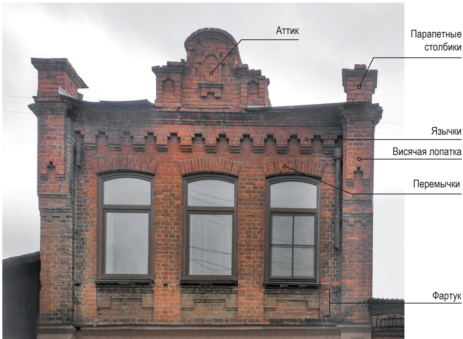
Фрагмент северного фасада
