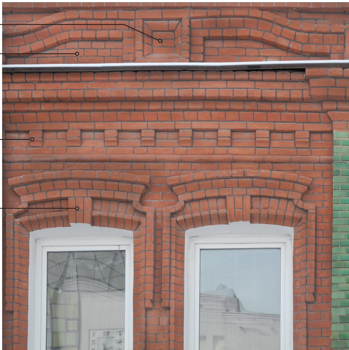
фрагмент восточного фасада
