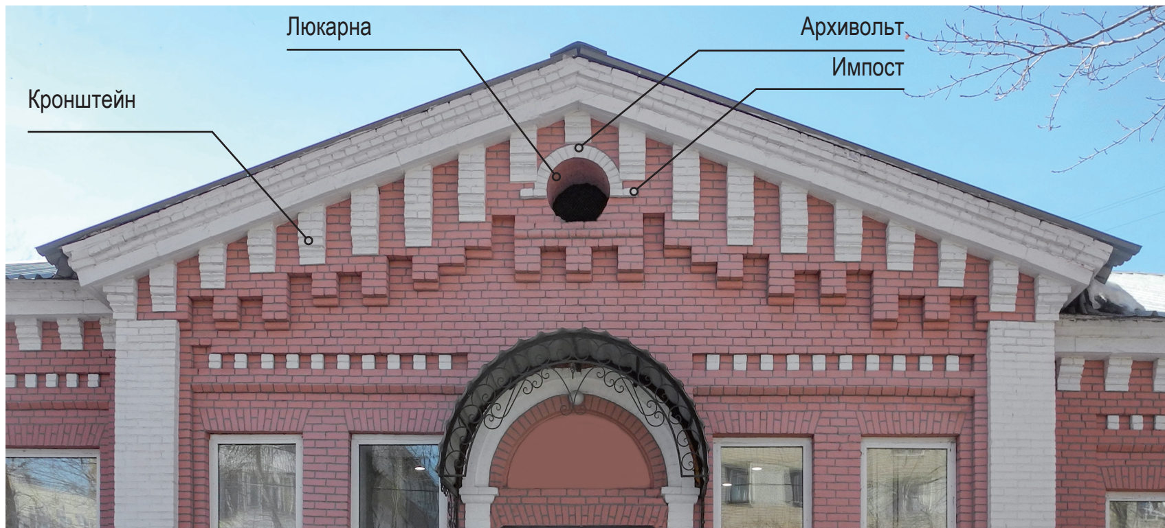
Фрагмент восточного фасада
