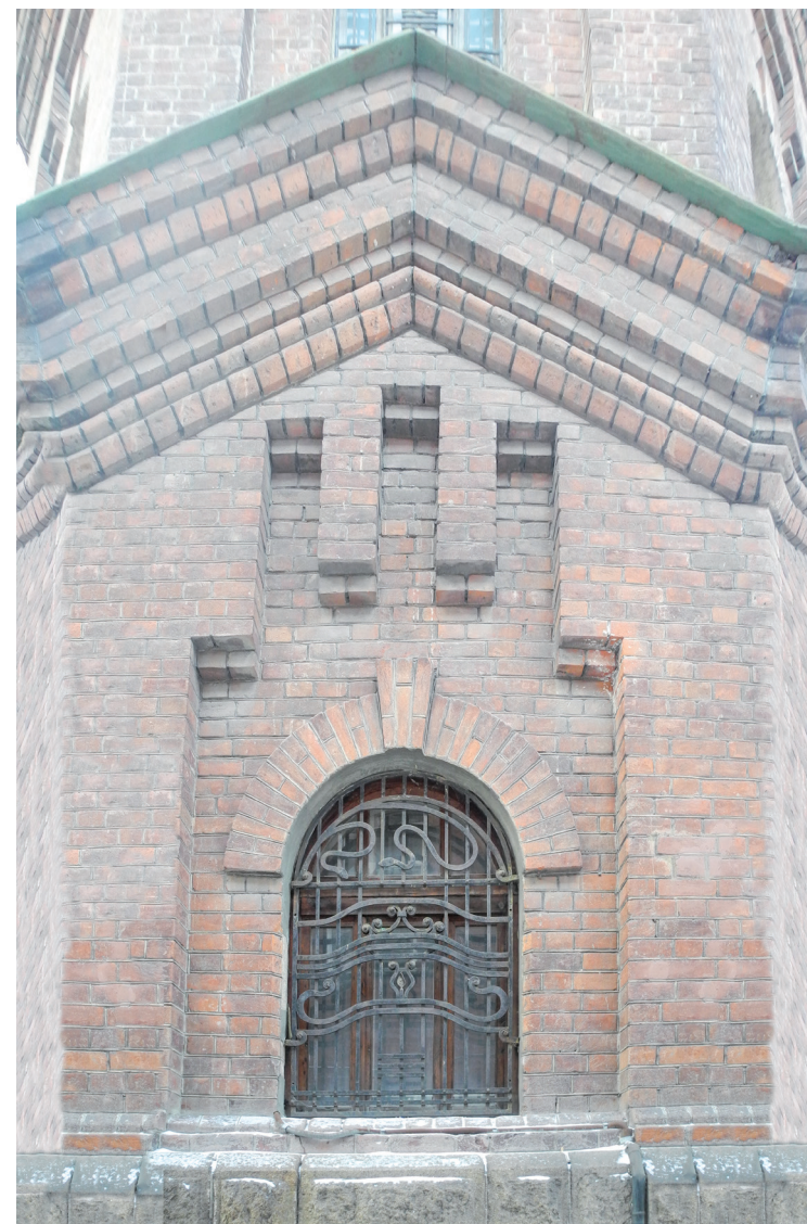
Фрагмент первого этажа с оконным проемом
