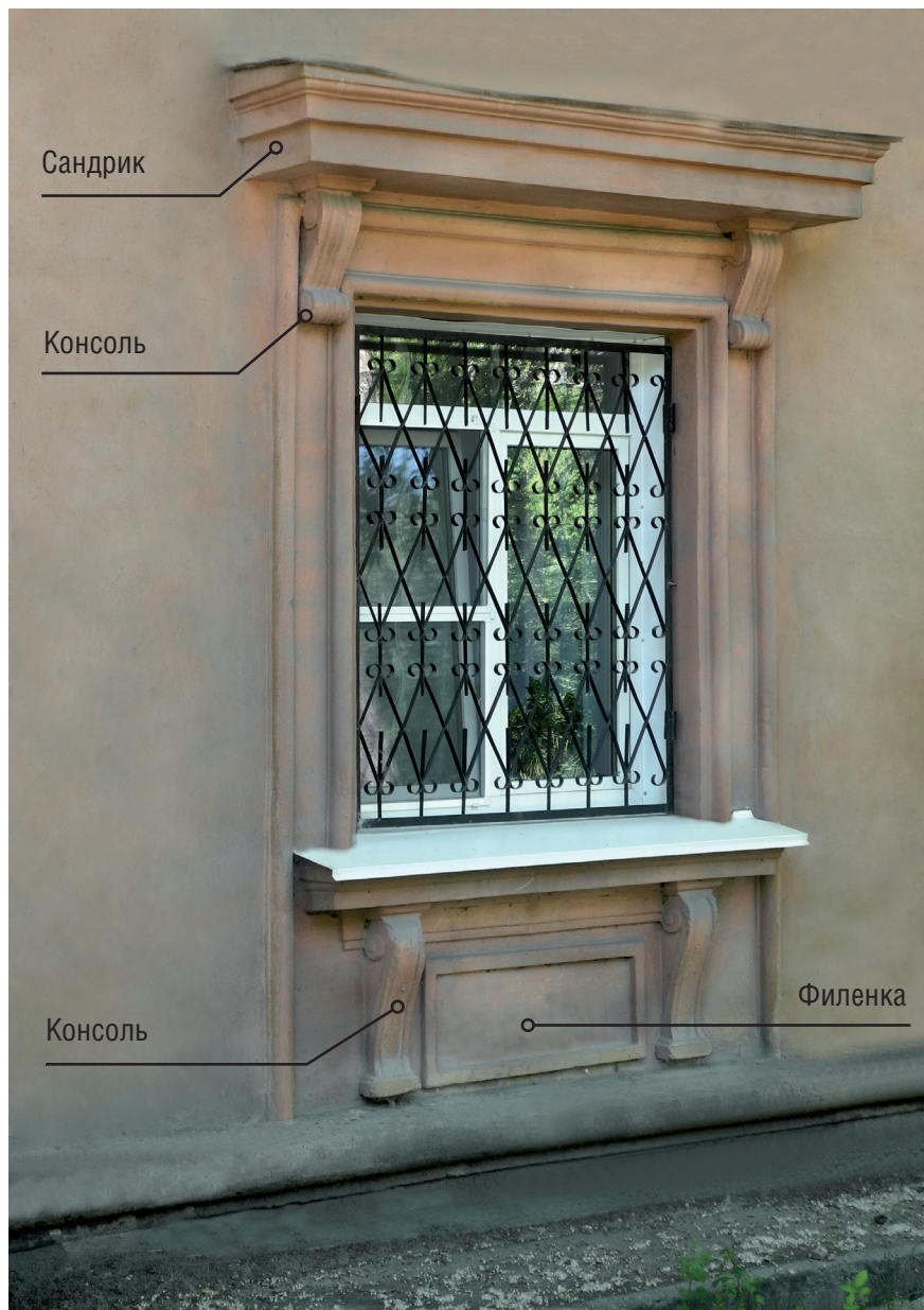
Обрамление оконного проема
