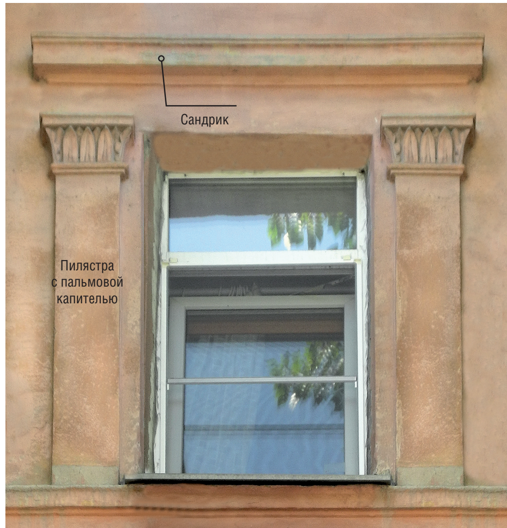
Обрамление оконного проема
