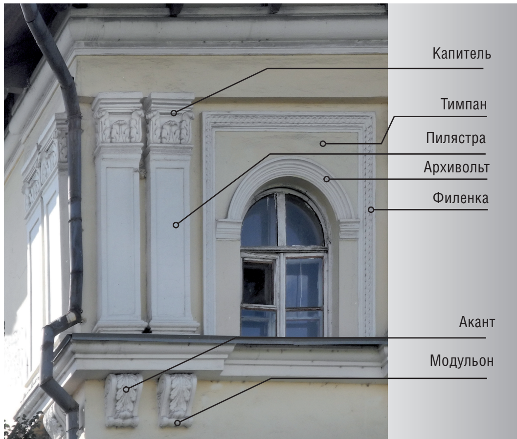
Фрагмент фасада с окном и пилястрами
