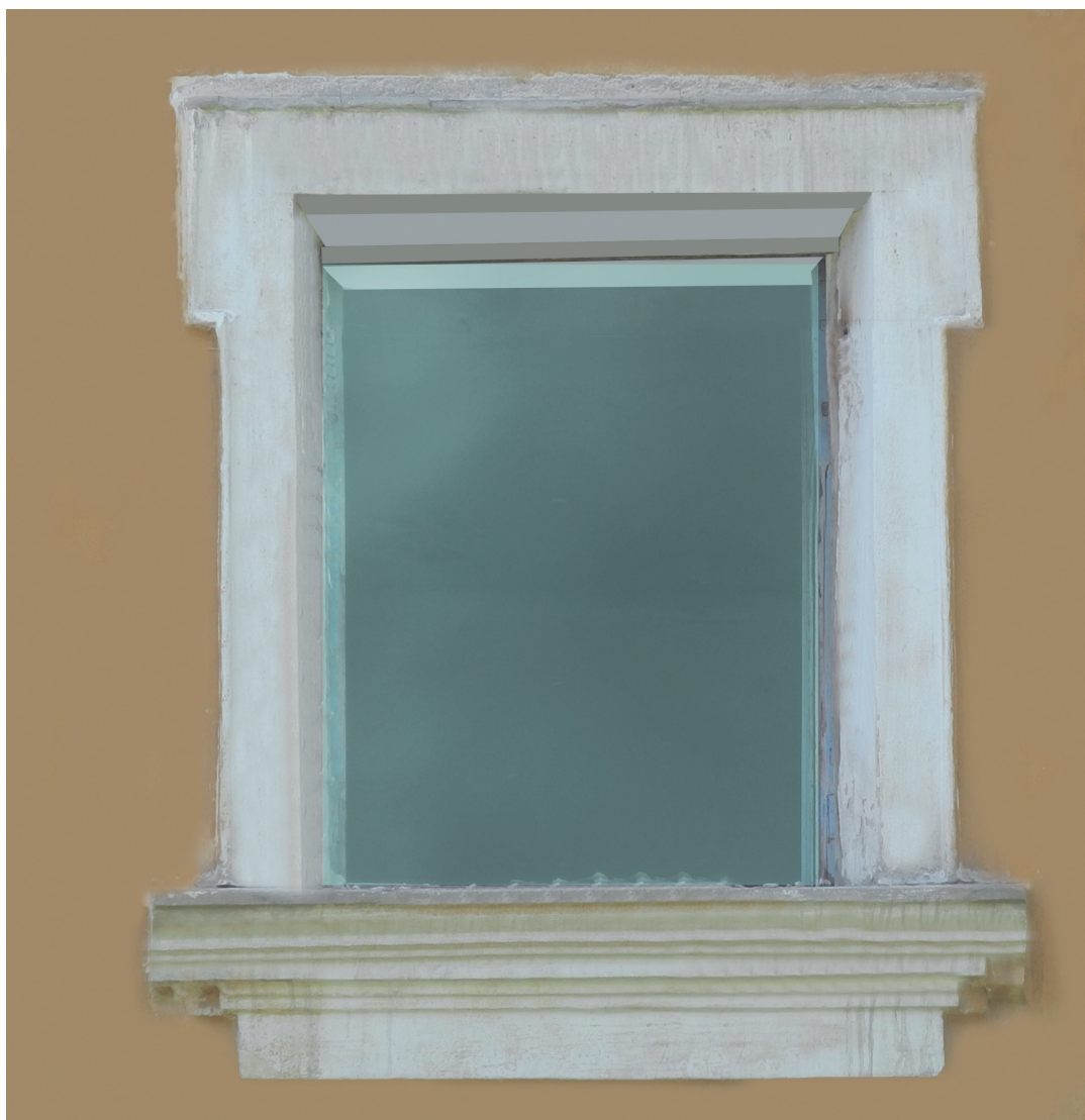
Оформление оконного проема
