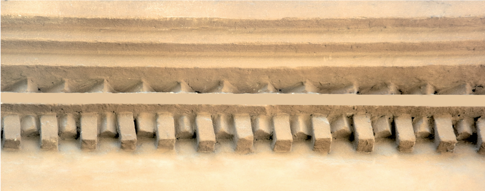
Карниз с сухариками
