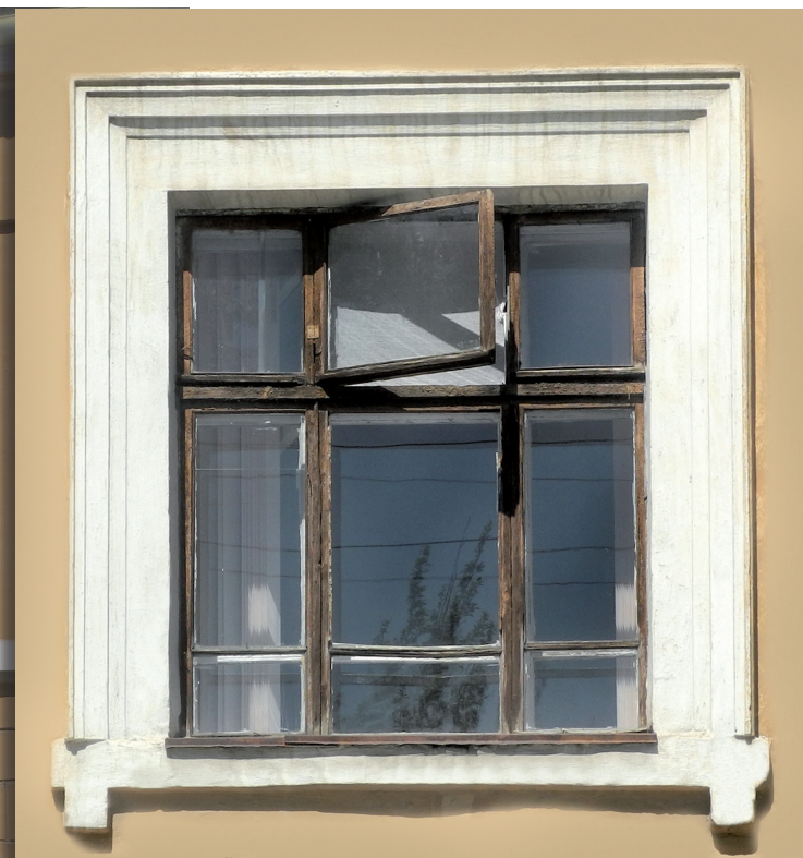
Оформление оконного проема
