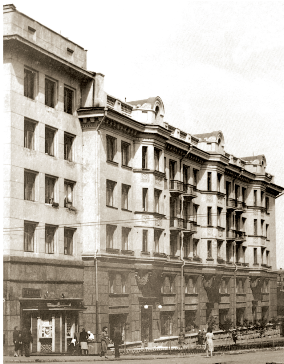
Рис. 1. Жилой дом по ул. Пушкина, 56 (архитекторы Е. В. Александров, И. Е. Чернядьев, В. А. Лукьянов)
