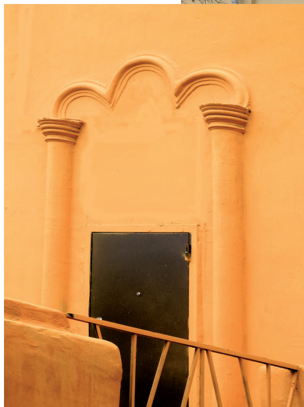
Оформление дверного проема
