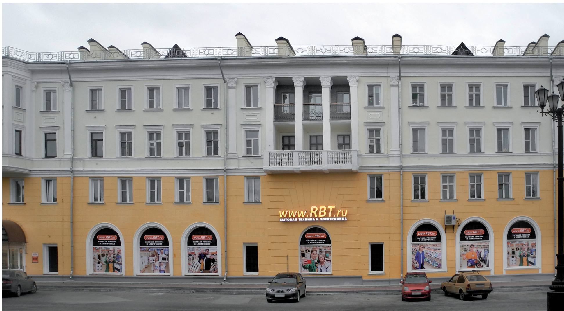
Северный фасад (со стороны ул. Б. Хмельницкого)
