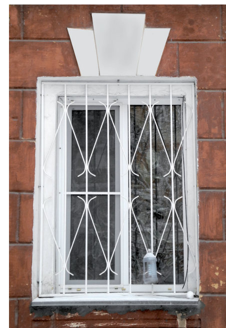
Веерный замок над оконным проемом
