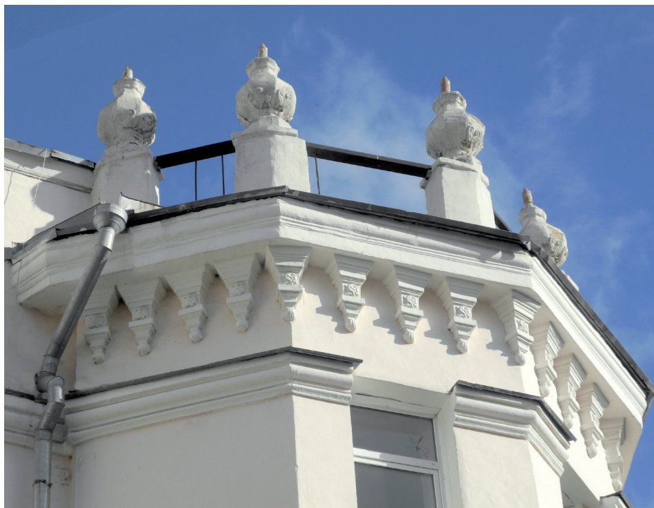
Верхняя часть эркера
