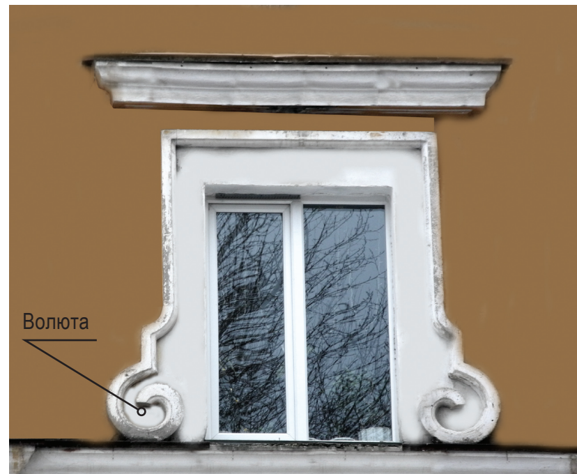
Оформление оконного проема
