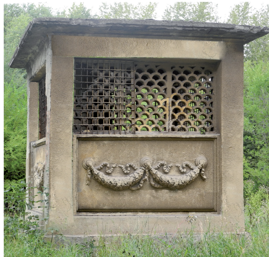
Выход ВЕНТИЛЯЦИОННОЙ ШАХТЫ
