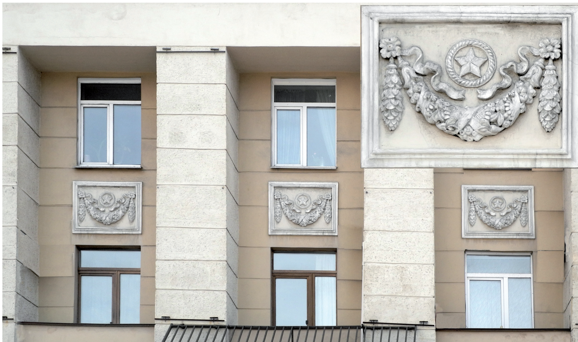
Фрагмент фасада с рустованными полуколоннами и филенками с лепными гирляндами
