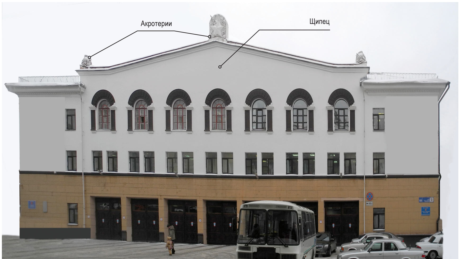
3-этажное здание Управления МЧС России по Челябинской области
