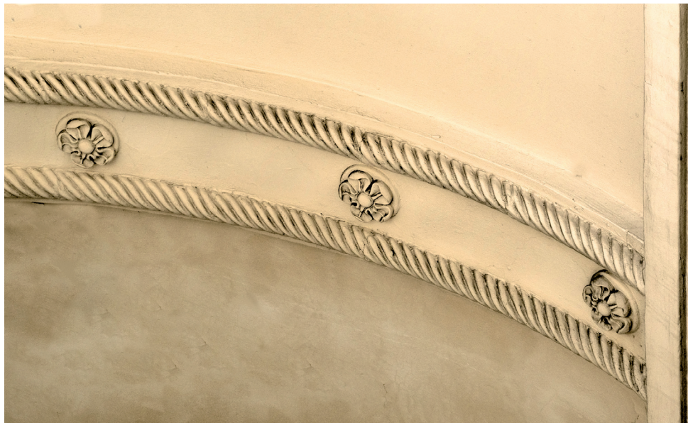
Лепной декор свода арки (фрагмент)
