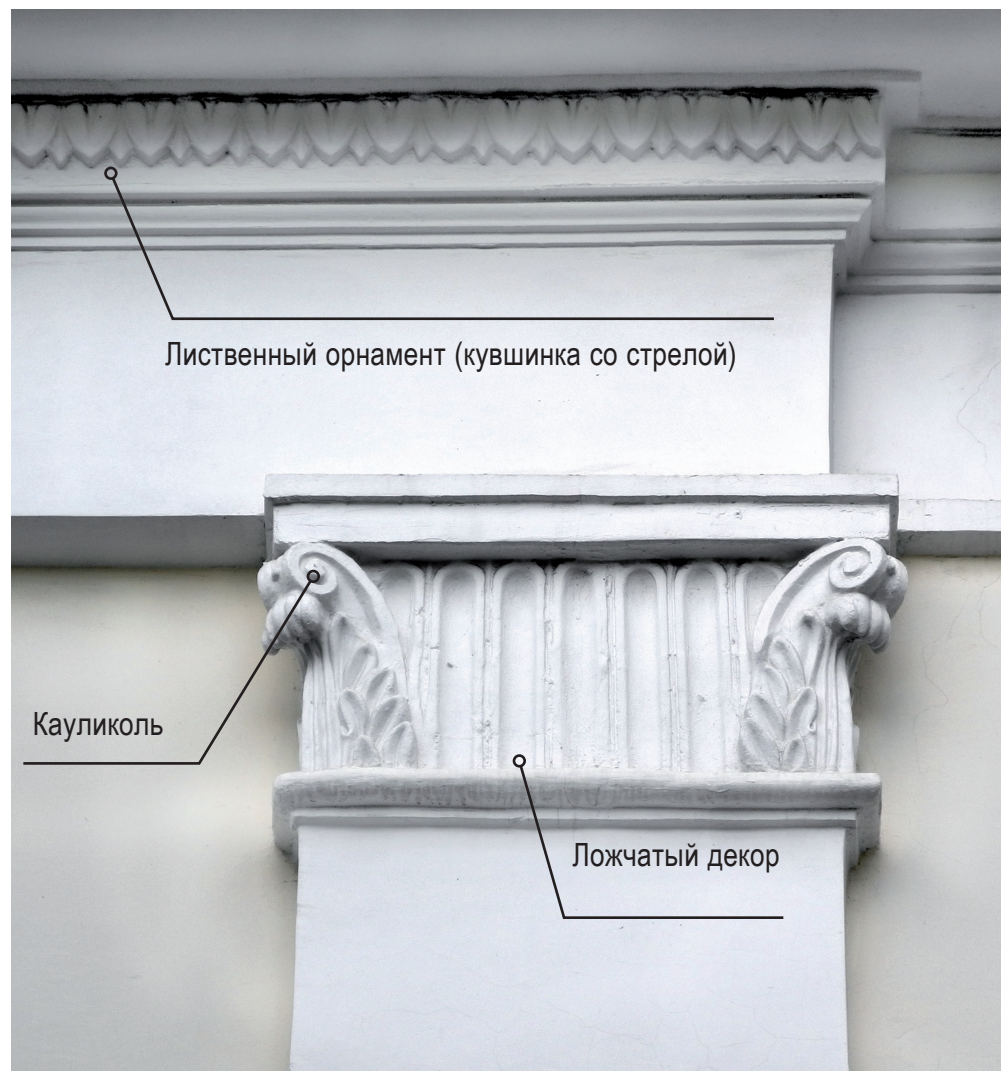
Фрагмент карниза и капитель пилястры
