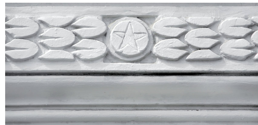
Элементы лепного обрамления дверного проема
