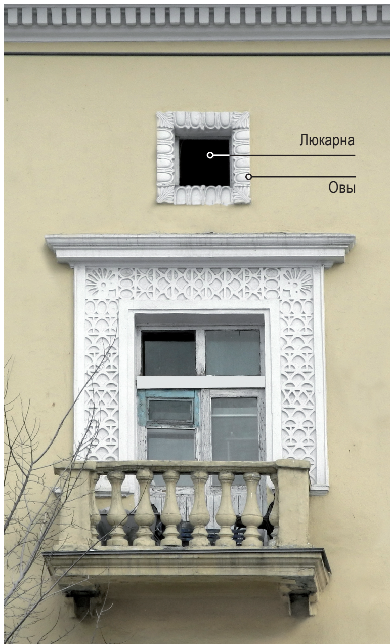
Оформление оконного проема
