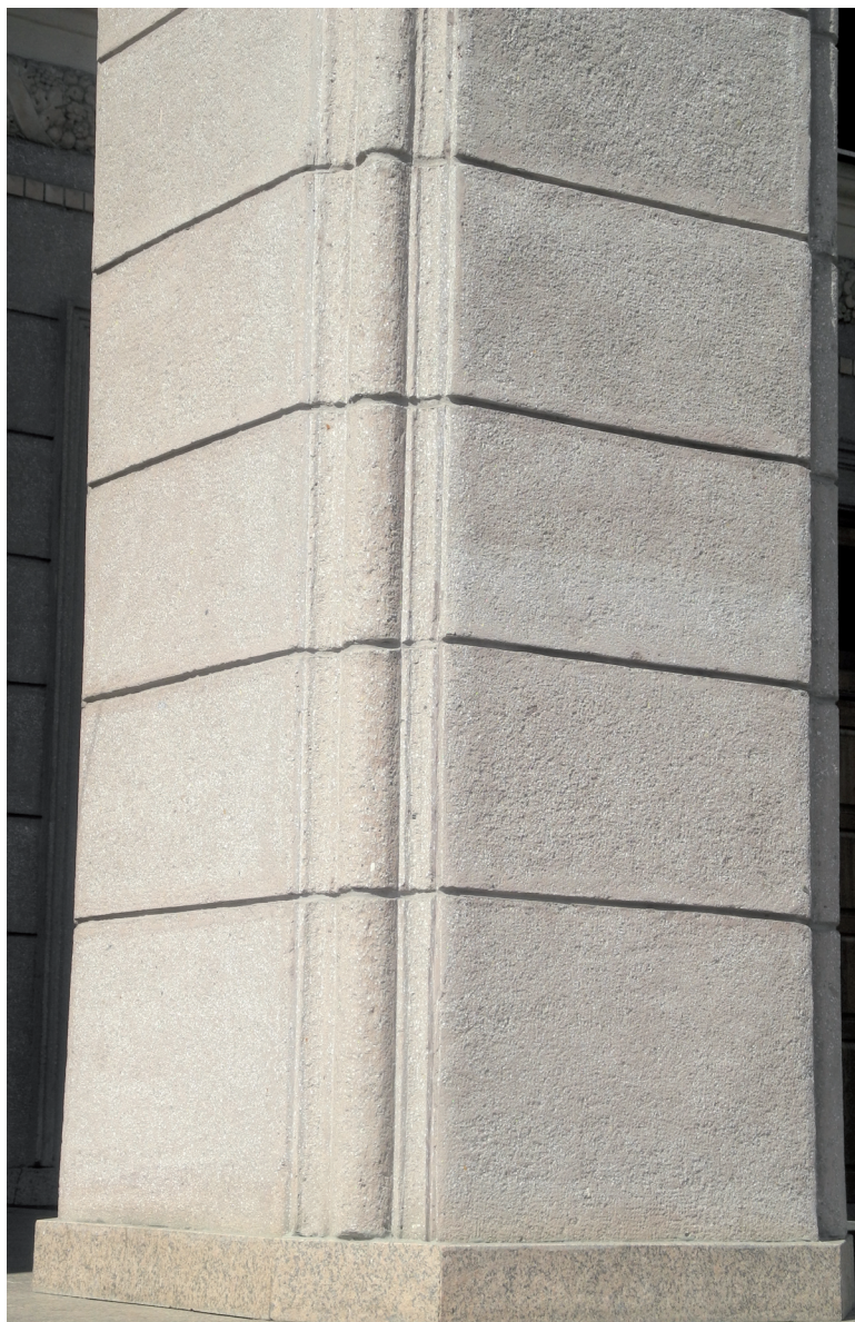
Нижняя часть колонны
