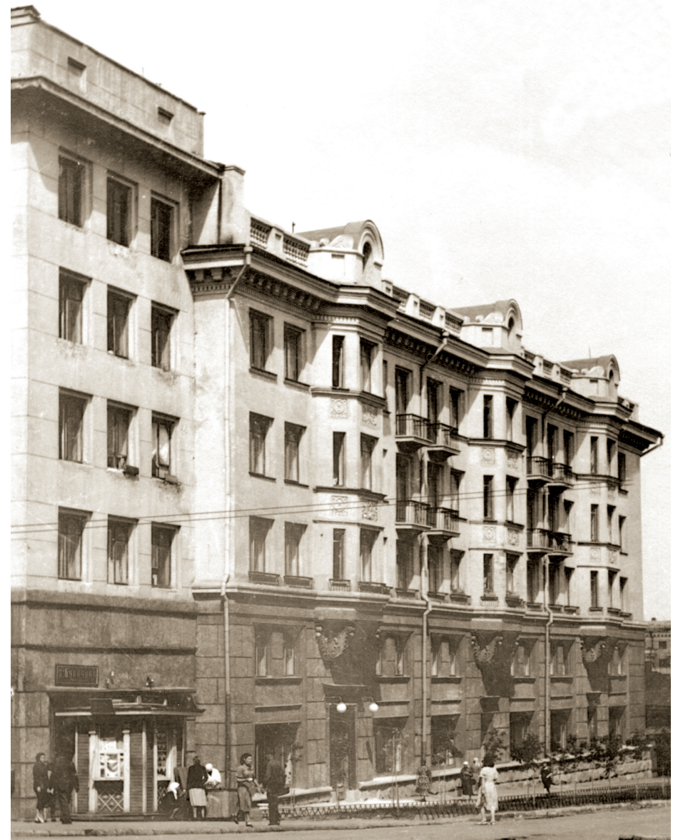
Рис. 1. Жилой дом по ул. Пушкина, 56 (архитекторы Е. В. Александров, И. Е. Чернядьев, В. А. Лукьянов)
