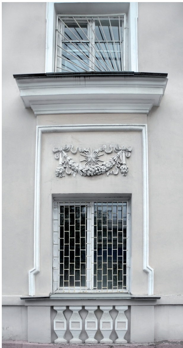
Обрамление оконного проема
