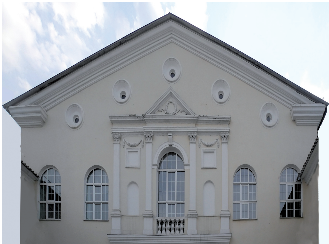
Фрагмент фасада со щипцом
