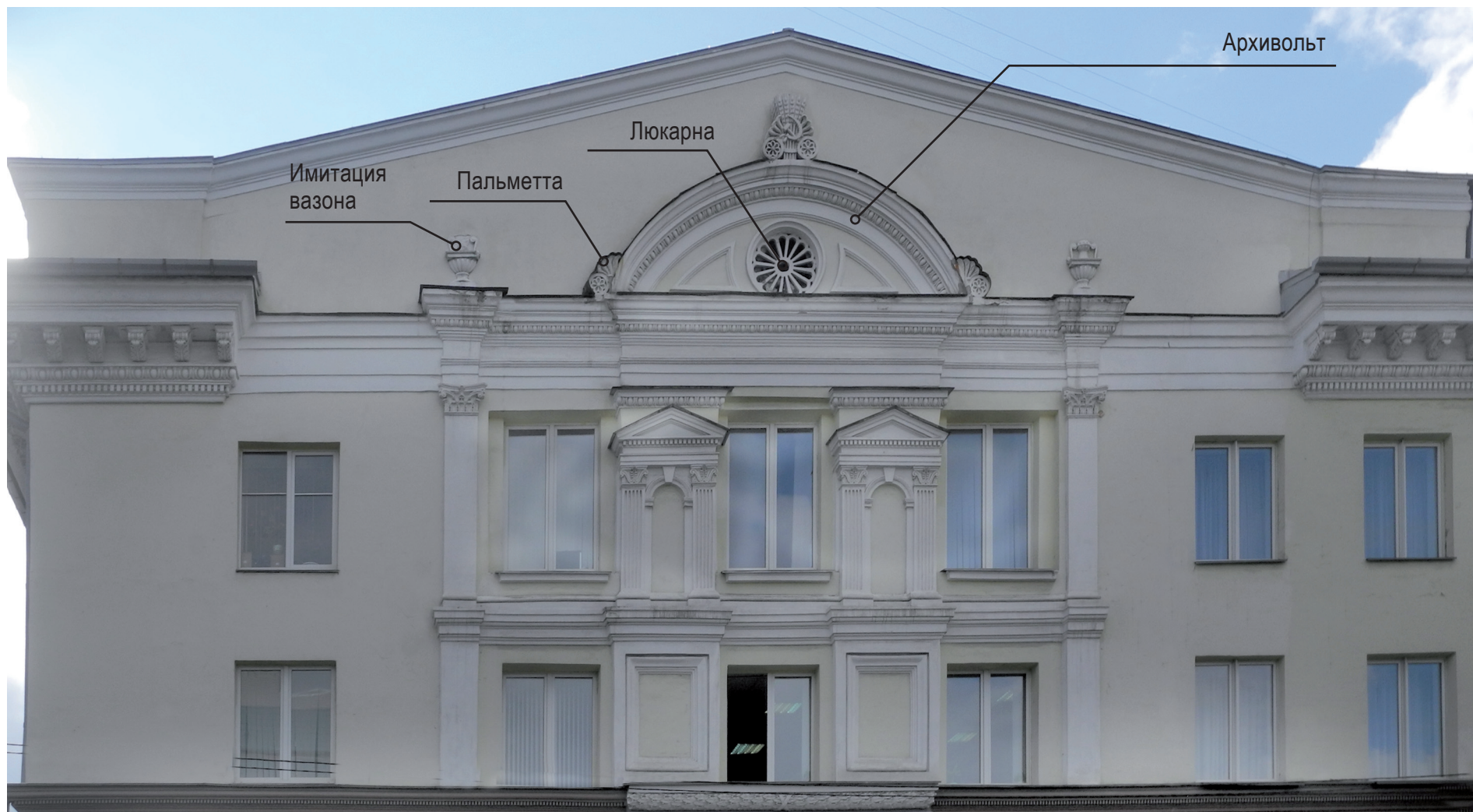
Фрагмент северного фасада
