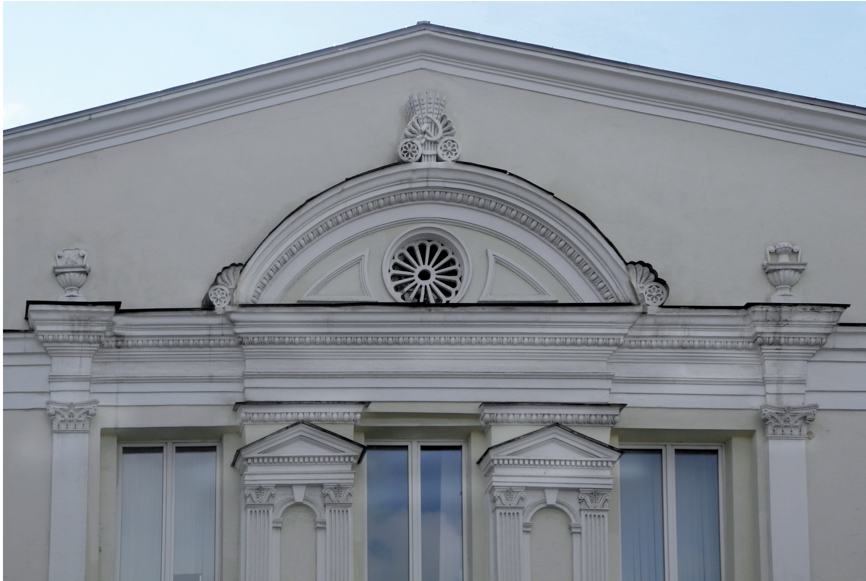
Фрагмент северного фасада
